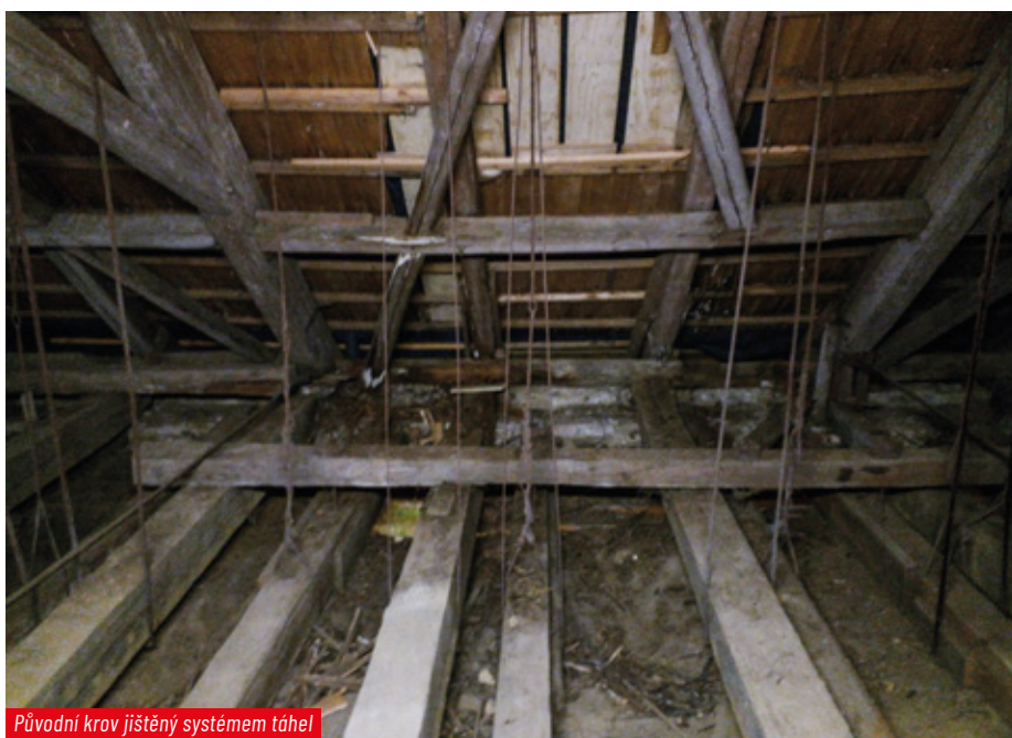
Rozpojená vazba v původním krovu
