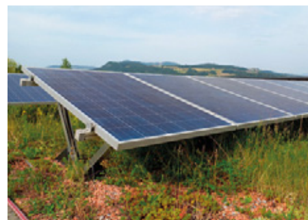
3) Biosolární střecha má konstrukci nesoucí FV panel vyvýšenou. Foto: archiv autora
