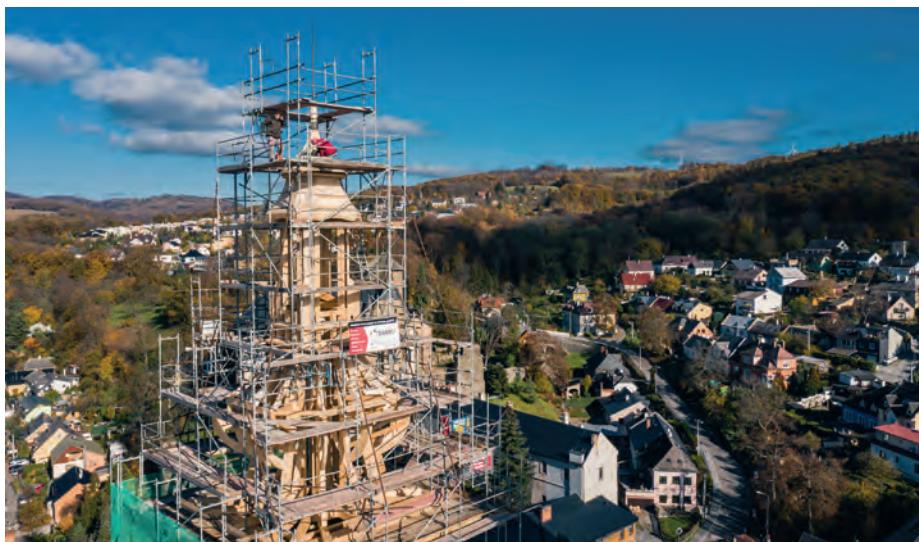
Kompletní konstrukce první věže, začátek prací na prkenném záklopu.
