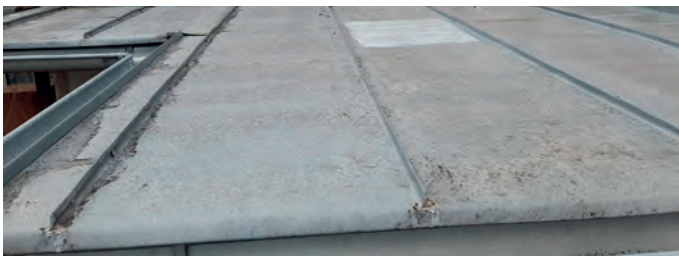
Bitumenová koroze
