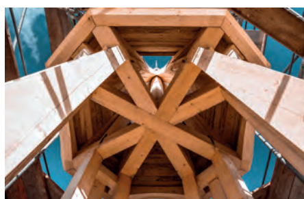
Poslední prstenec věže držíci hrotnici.
