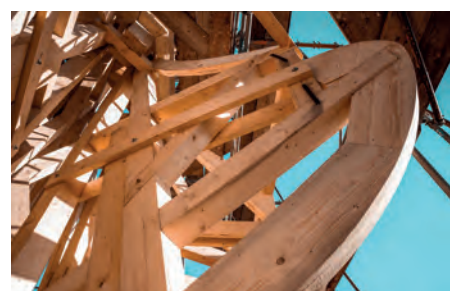
Detail konstrukce ramenátu.
