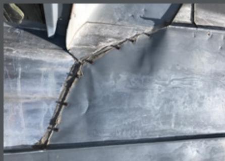
Spojení plechů vyžaduje zručnost klempíře a kde chybí zručnost, nastupuje kreativita umělce.
