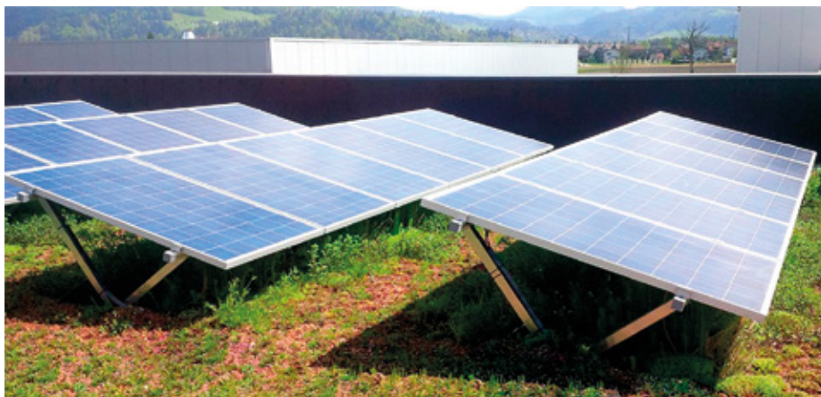
5) Zelená střecha v kombinaci s fotovoltaikou je výborným využitím plochy střechy (foto: Baulinks.de)
