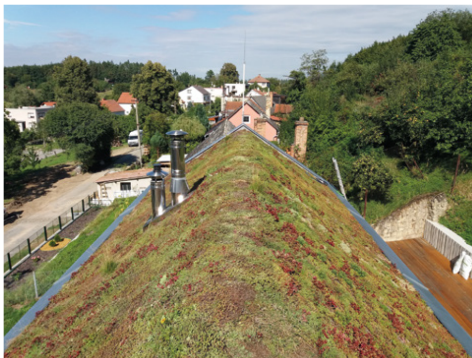
2) Šikmá zelená střecha ve sklonu 35°, šikmé zelené střechy se realizují s extenzivní vegetací (foto: GreenVille)
