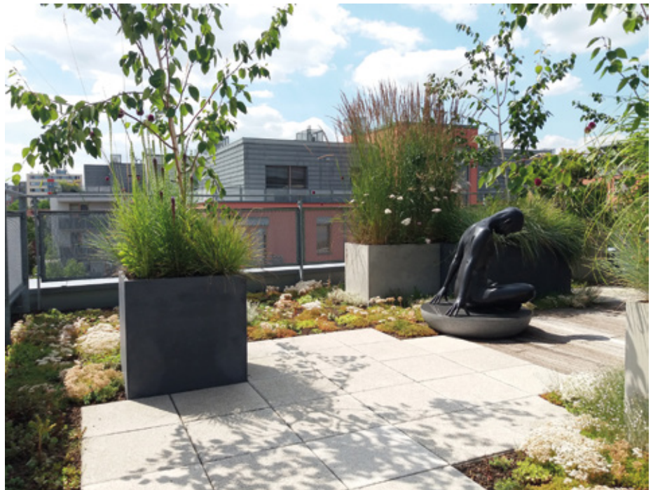
4) Pobytová zelená střecha s polointenzivní vegetací na terase bytového domu (foto: GreenVille)
