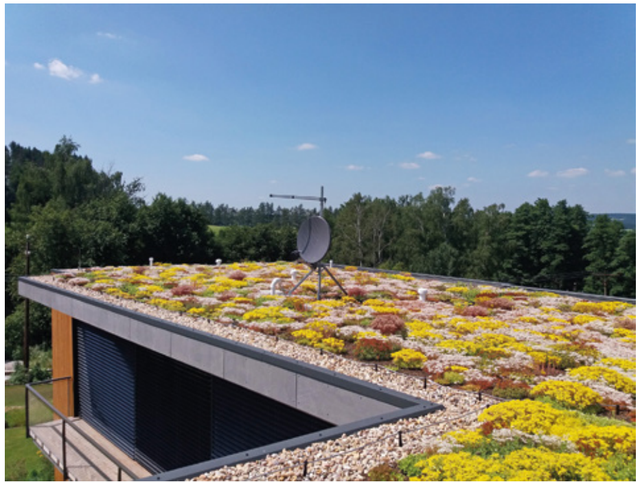
3) Extenzivní zelená střecha s vegetací složenou výhradně z rozchodníků, které jsou jedny z nejobdnějších rostlin v našich podmínkách (foto: GreenVille)
