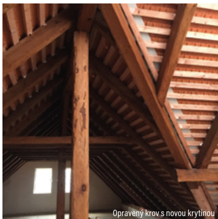
Opravený krov s novou krytinou
