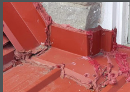
Silikonové blues - tohle je opravdová kráska! Klempířské prvky pojistil neznámý umělec silikonovými výtvary. Při troše dobré vůle v nich můžete rozeznat růžičky, vlnky a jiné bizarní tvary.
