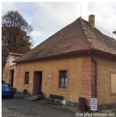
Stav před rekonstrukcí
