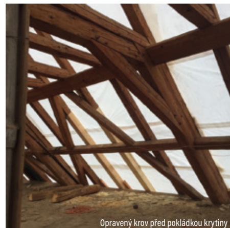
Opravený krov před pokládkou krytiny
