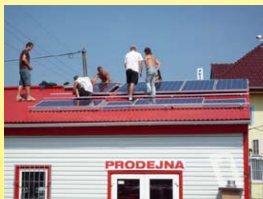
Pokládka panelů na střeše naší prodejny v Plzni...
