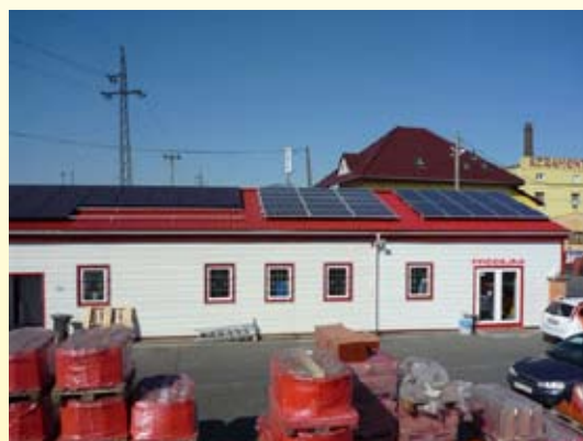
Realizace ještě není dokončena, chybí ještě montáž několika panelů...
