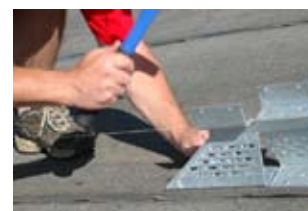
přibíjení kovového drážku
