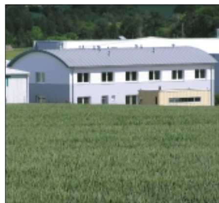
Budova firmy DSK v Jesenici. Použitý materiál Prefalz – barva světle šedá. Zajímavostí stavby jsou velmi dobře vyřešené průchody střechou.
